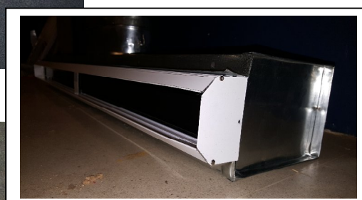
1a) Diffuser with plenum
